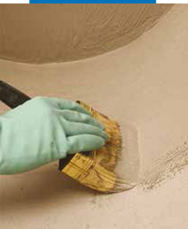
Нанесение гидроизоляции с помощью кисти
