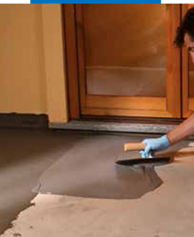
Нанесение гидроизоляции на террасе с помощью шпателя
