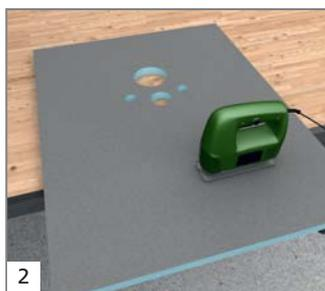
2 Затем с помощью узкой ножовки вырезается подходящая выемка для клавиши слива.
