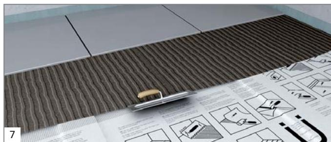
7 После затвердевания тонкослойного раствора можно осуществить укладку плитки. Укладка гидроизоляционного полотна может быть также осуществлена стык в стык. В этом случае швы между полосами полотна должны быть проклеены уплотнительной лентой wedi нанесенной на цементную смесь.
