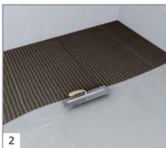
2 Нанести на основание тонкий слой цементного раствора и разгладить его зубчатым шпателем 4 или 6 мм.
