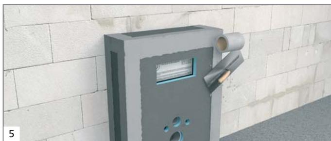
5 на места стыков и соединений на тонкий слой цементного раствора укладывается армирующая лента wedi *Tools* или самоклеющаяся армирующая лента weid *Tools*. В зонах повышенной капельной нагрузки/брызг воды стыки проклеиваются гидроизоляционной лентой wedi *Tools* или клеем-герметиком wedi 610.
