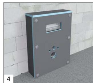
4 Теперь вырезанные ранее полосы панели I-Board крепятся вверху и по бокам с помощью клея-герметика wedi 610.
