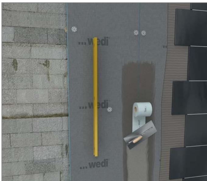
При очень большой неровности стены следует использовать строительные панели wedi толщиной 20 мм и более. Каким бы изношенным и разбитым не было старое основание, в результате получатся чистые и ровные стены, обеспечивающие долговременную защиту от влаги и теплоизоляцию на долгое время.
