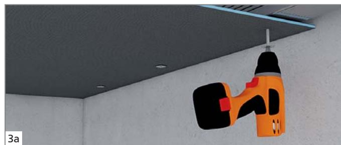
3a Крепление плиты на шурупы с использованием шляпок для дюбелей wedi *Tools*. Места монтажа дюбелей определяются инструкциями и указаниями для деревянных и металлических каркасных конструкций.
