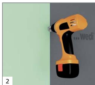
2 Выровненная строительная панель wedi закрепляется при помощи шляпок для дюбелей и деревянных саморезов wedi *Tools*.
