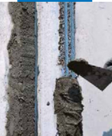
Нанесение раствора мастерком
