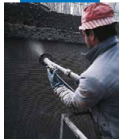
Канал гидроэлектростанции в г. Бертини-Робьятте (Область Комо): нанесение напылением
