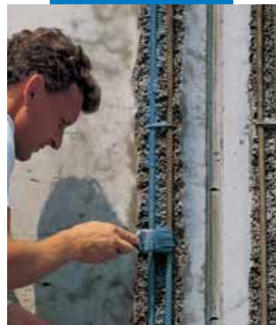
Нанесение смеси Mapofer
