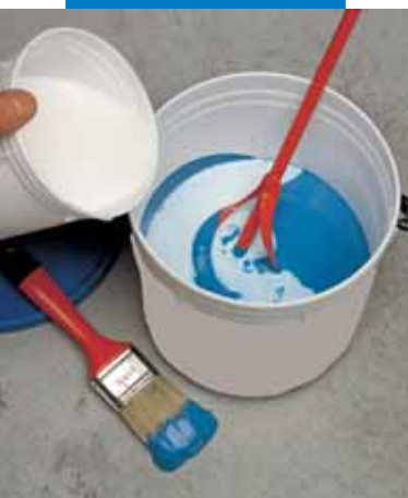
Приготовление смеси Mapefer
