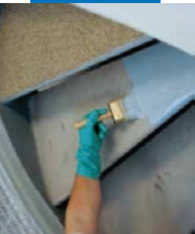
Нанесение первого слоя Марескоат I 24 на бетон
