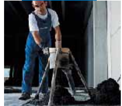
Batching a Mapecem mix
