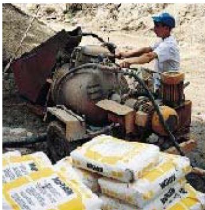
смешивание МАРЕСЕМ автоматической насосной станцией
