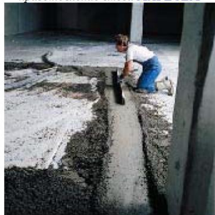
подготовка выравнивающего слоя
