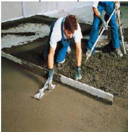
окончательное выравнивание
