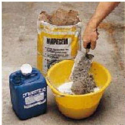
приготовление связывающего раствора с PLANICRETE
