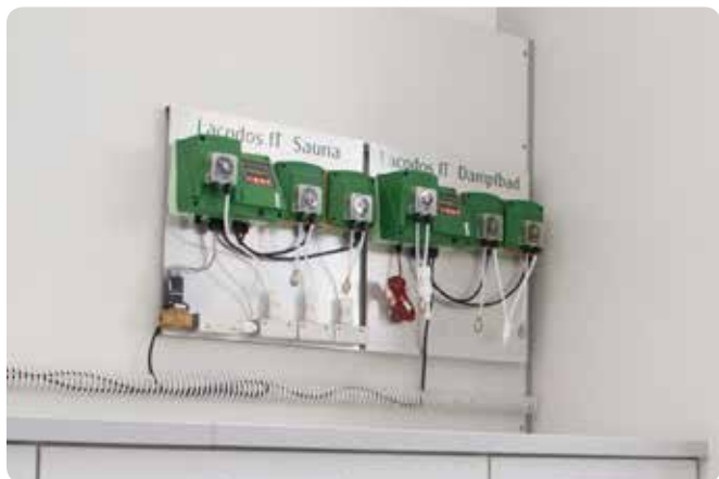
Тестовое оборудование - насосы для дозирования ароматов
